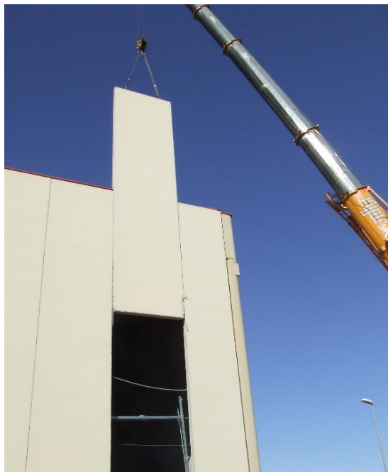
1-DESMONTAJE Y ACOPIO DEL PANEL
