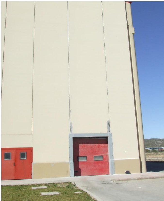
4-REPARACIÓN DE DESPERFECTOS EN EL PANEL, PREVIO AL PINTADO
