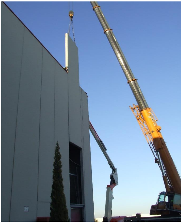
3 -MONTAJE DE PANEL SOBRE NUEVO PREMARCO
