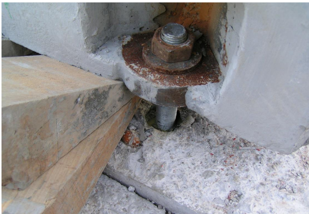
DETALLE DE UNIÓN VARILLA A CIMENTACIÓN FRESCA
