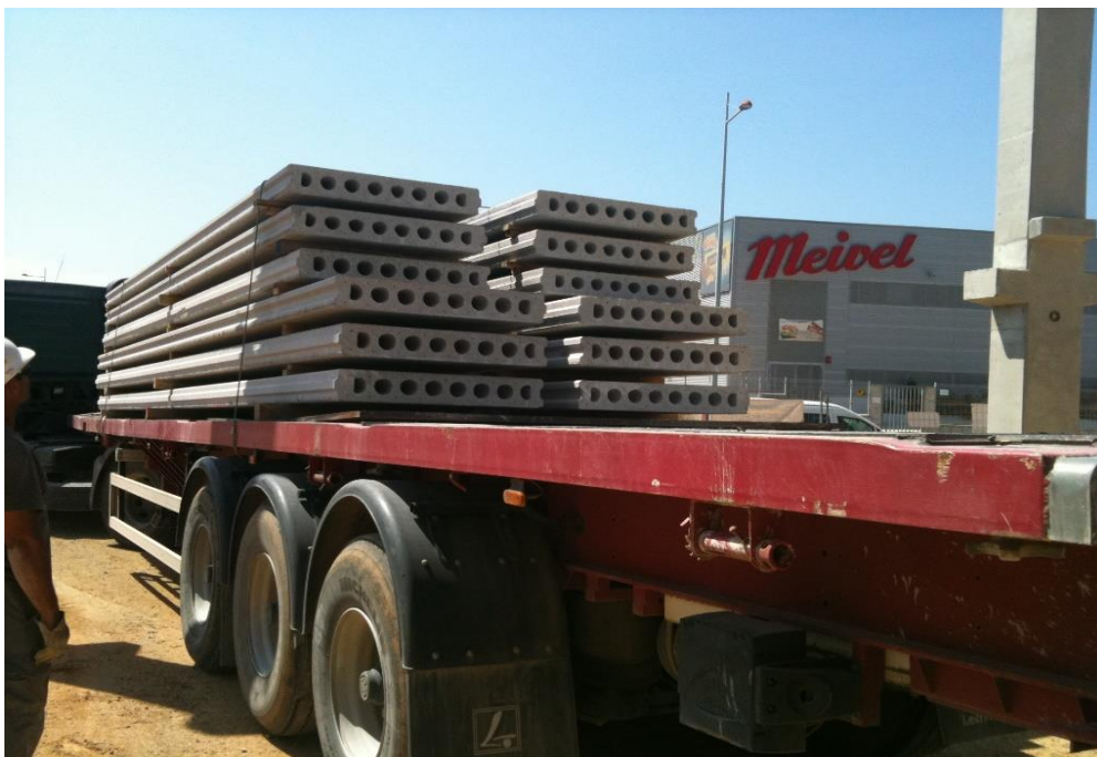
CAMIÓN CARGADO DE PLACAS ALVEOLARES SIMILAR AL QUE SE ESTABA DESCARGANDO
