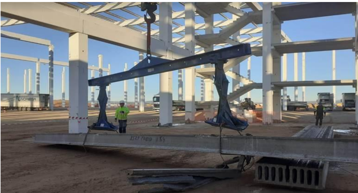
OTRA PLACA ROTA POR PINZAS SIN TOPE Y ANCHO DE MORDAZA ESTRECHO
